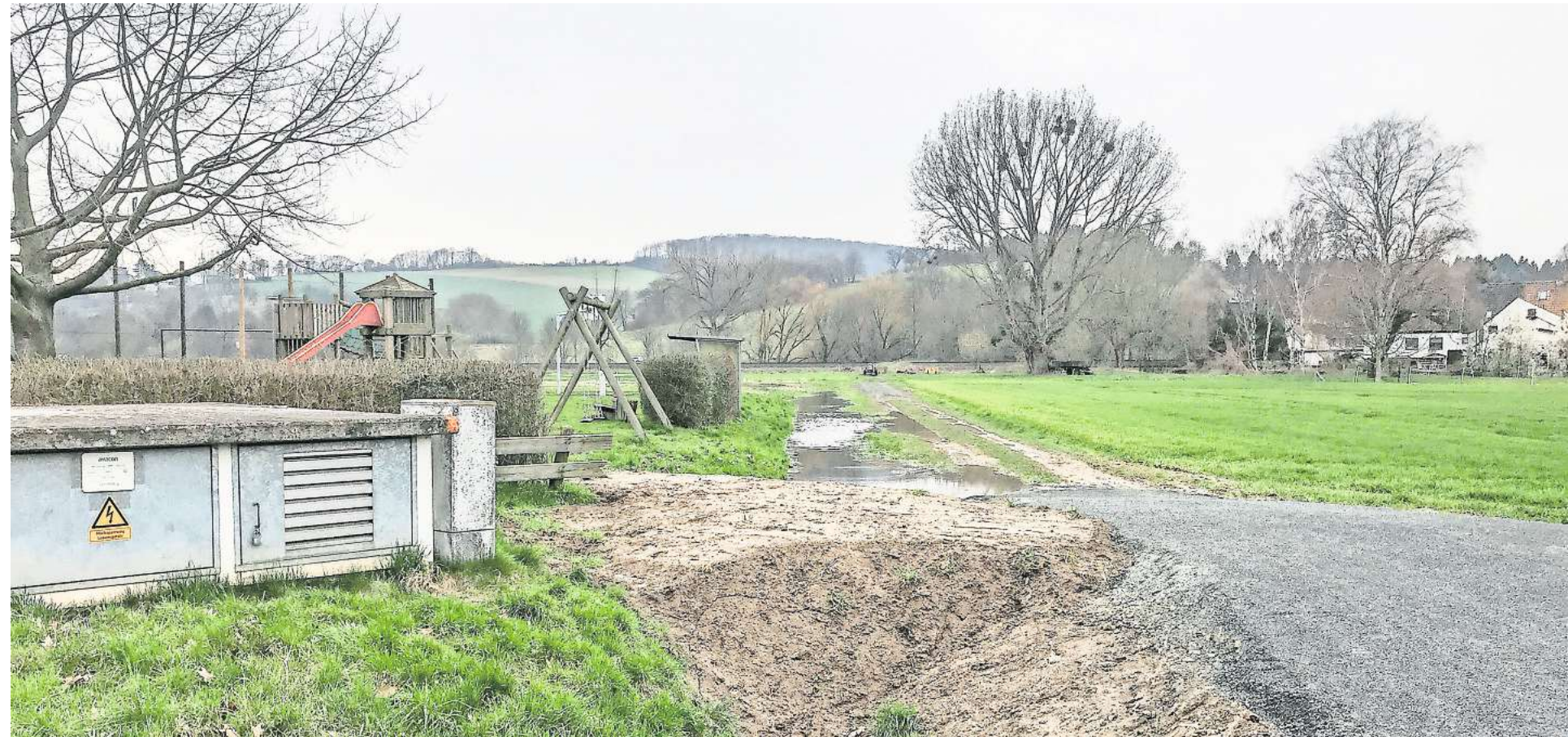
In Höhe des Spielplatzes am Sonnenberg staut sich das Oberflächenwasser. Die Überführung zum Spielplatz ist inzwischen geschlitzt, damit das Regenwasser ablaufen kann. In Kürze wird das Gelände noch ordnungsgemäß entwässert, sagt Helfried Basse.
