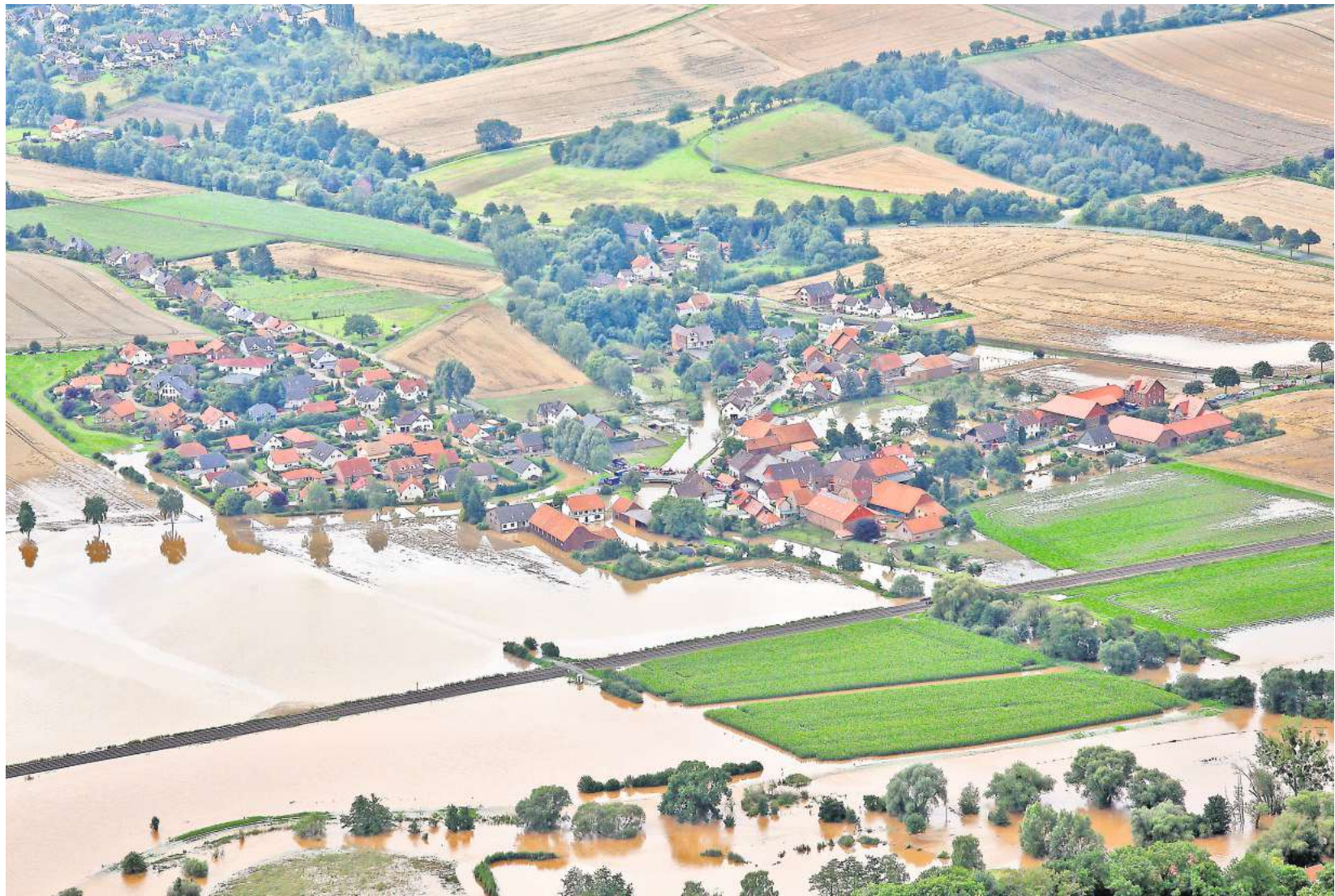
2017 war Klein Dungen vom Hochwasser schwer getroffen. Östlich der Lamme ist der Schutz vor den Fluten inzwischen fast fertig, westlich haben die Arbeiten noch nicht einmal begonnen. ARCHIVFOTO: CHRIS GOSSMANN
